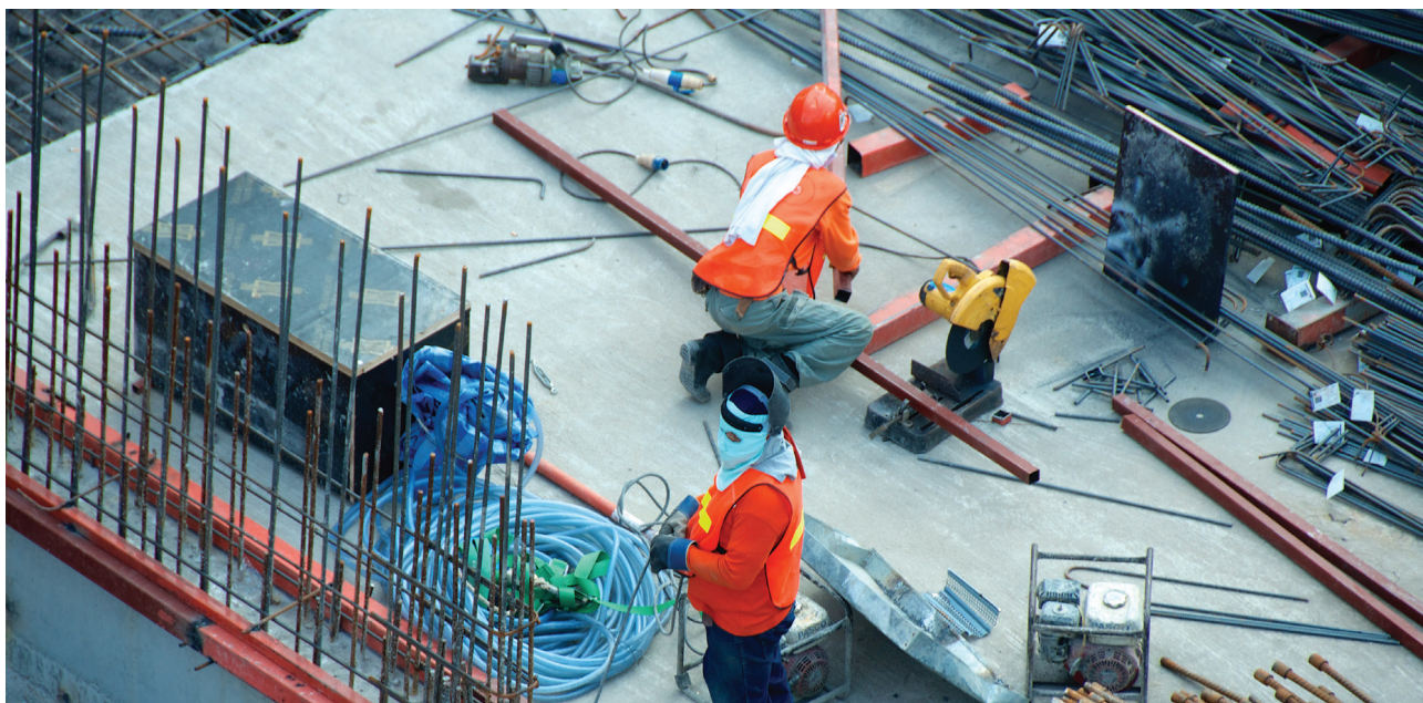
Lao động di cư làm việc tại một công trường xây dựng ở Thái Lan. © Etienne Girardet/Unsplash
